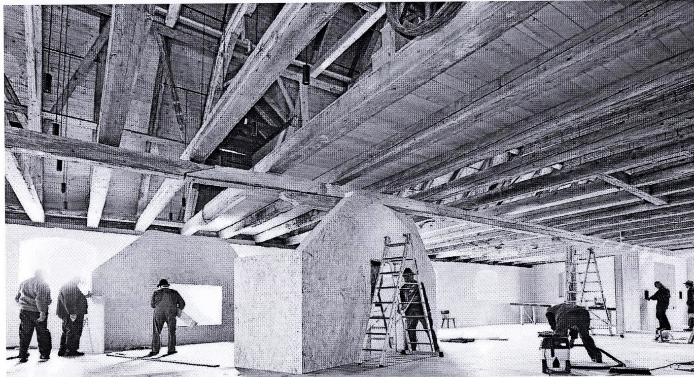
Fast schon historisch: die Aufnahme von den Aufbauarbeiten im Fischerbau ist rund sechs Wochen alt.
